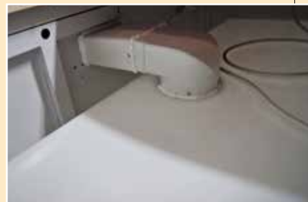
Тумба с пластиковым покрытием с вытяжкой (вид сверху)
